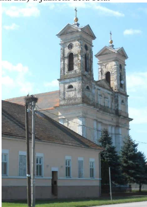
Slika 2.2. Objekat na kome će biti instalirana BS.
