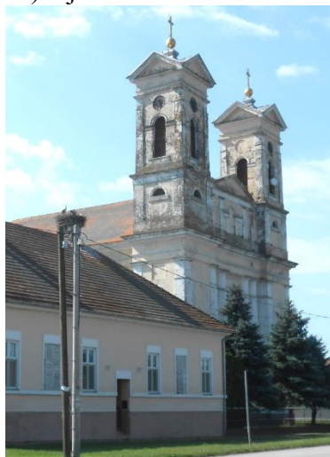
Slika 2.2. Objekat na kome će biti instalirana BS
